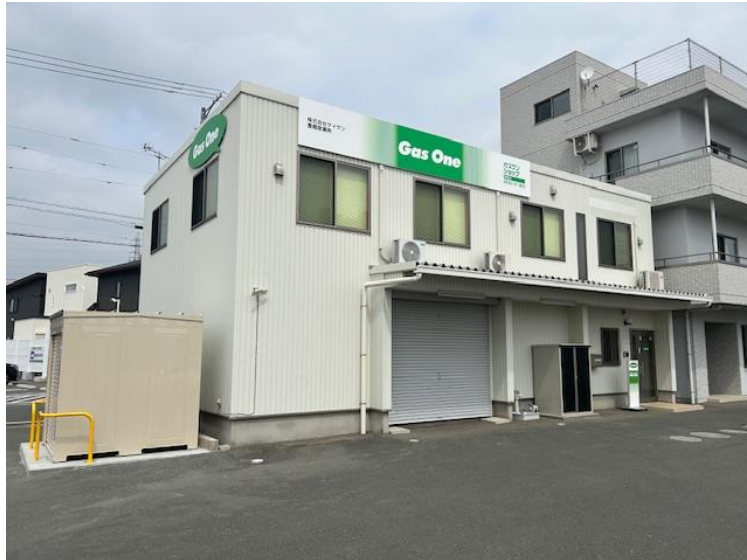
【写真 2】 営業所外観
